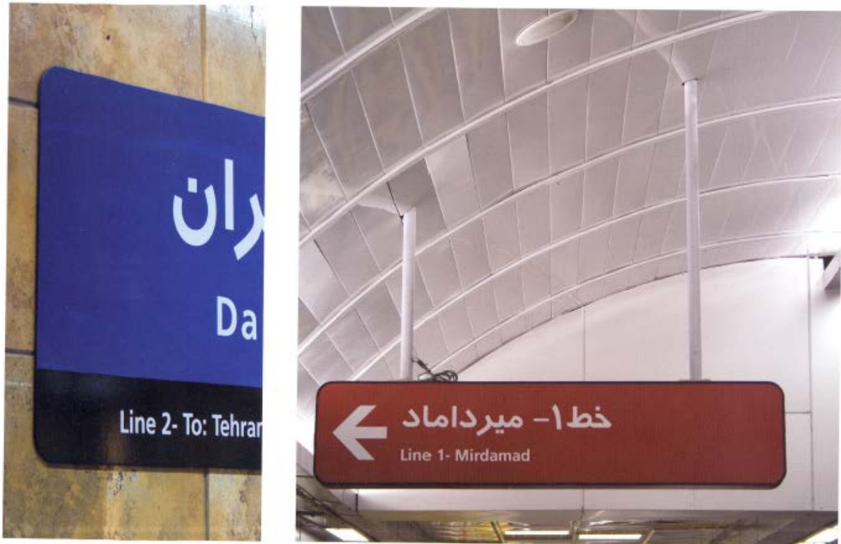
شکل ۸-۲۳ نمونه شیوه‌های نصب عمومی تابلوها
