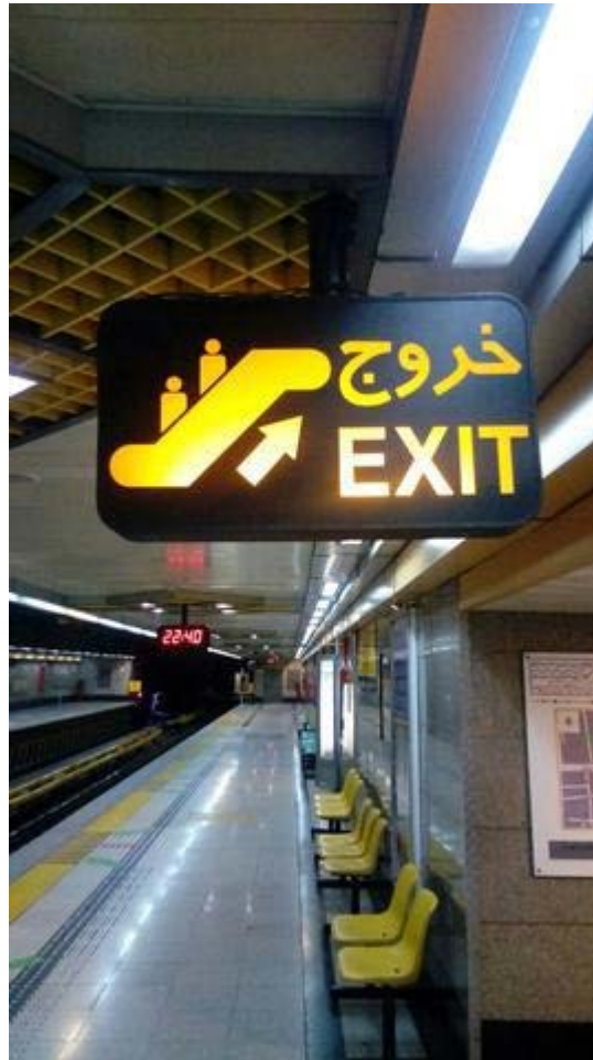
شکل ۸-۱۳ نمونه تابلو خروج از سکو با پله برقی
