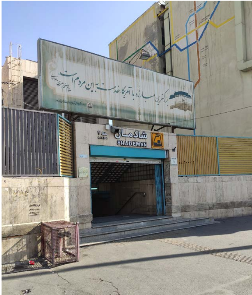
شکل ۸-۹ نمونه تابلو ورودی ایستگاه
